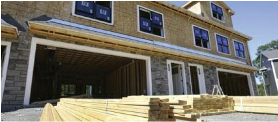
미들턴의 한 주택 공사 현장에 쌓인 목재
