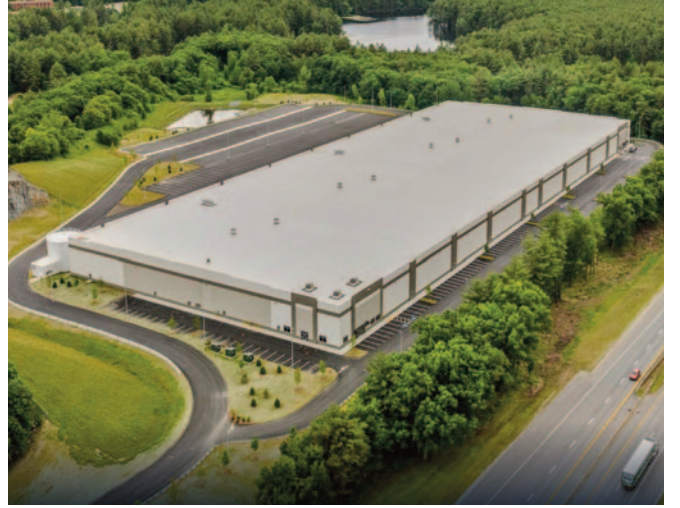
뉴햄프셔 매리맥 소재 50 로버트 밀리건 파크웨이(50 Robert Milligan Parkway in Merrimack, NH)의 창고 건물
