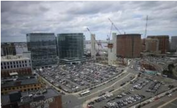
사진 중앙의 주차장 부지에 아마존의 새로운 테크 허브가 들어선다
