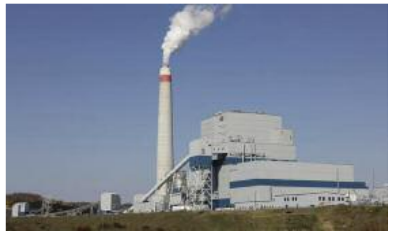
웨스트버지니아주의 석탄 화력발전소
