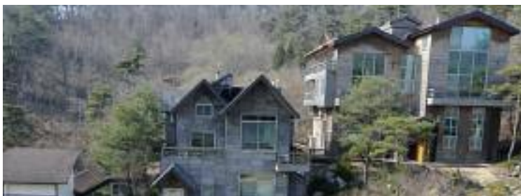
사회지도층 인사들에게 성접대를 했다는 의혹이 제기된 건설업자 윤모씨의 강원 원주 별장.
