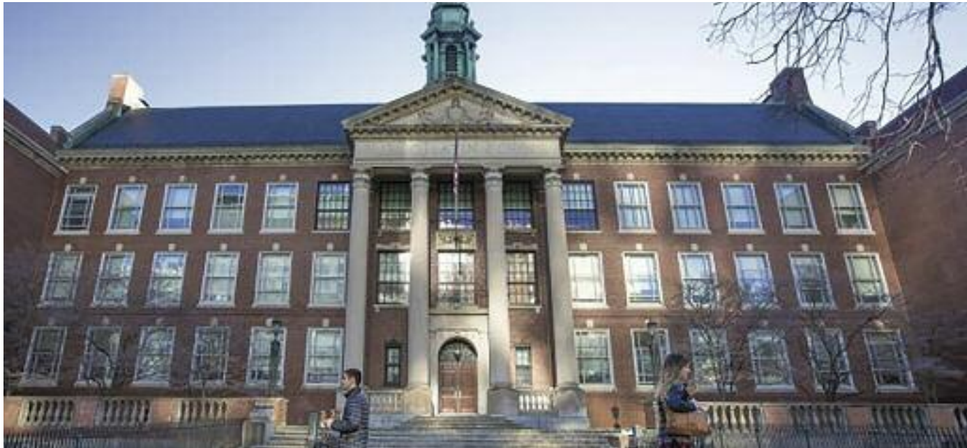
미국내 최초의 공립고등학교인 보스톤라틴고등학교는 매사추세츠내 최고 고등학교로 선정됐다
